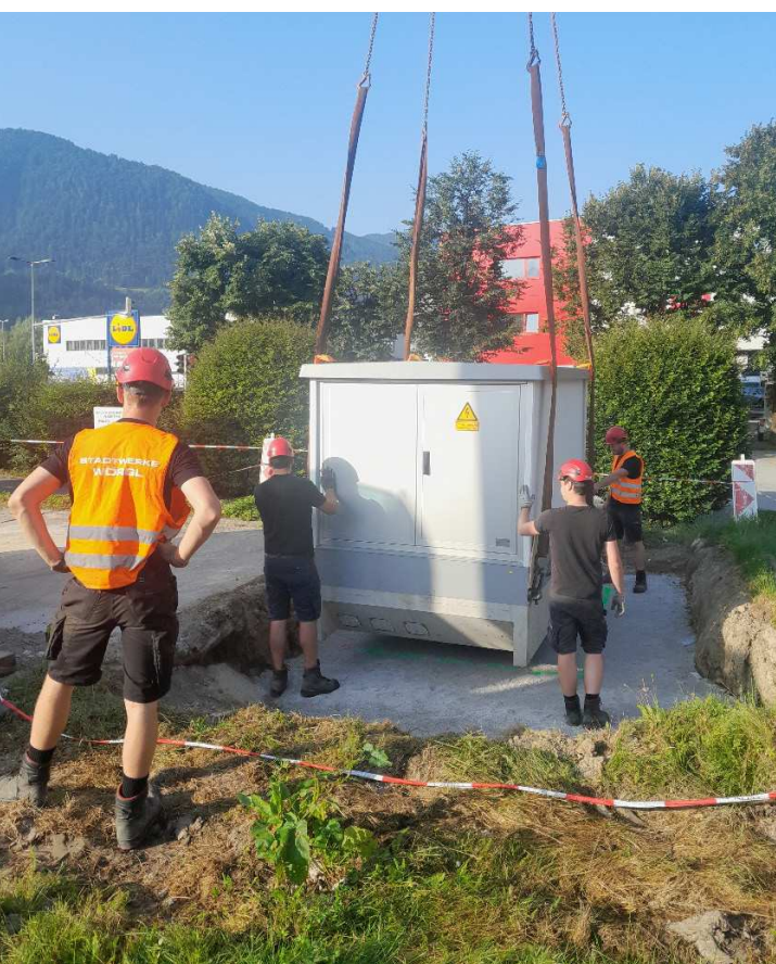
Fotos: Stadtwerke Wörgl
